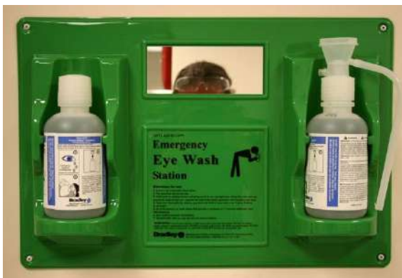
Figura 17. Dispositivos especiales para salpicaduras de productos químicos en los ojos.
