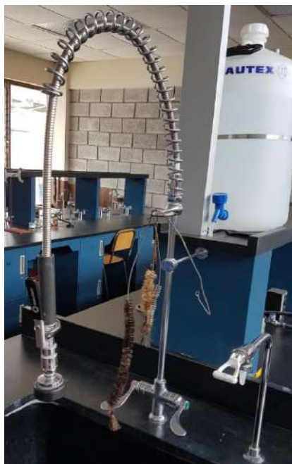
Figura 1. Adaptaciones a tubos de pilas para usarse como dicha de seguridad o lavaojos.
